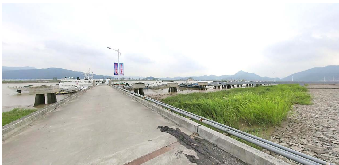
图 2.3-1 健跳渔港浮码头
